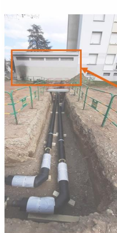
Sous Station Thermique (SST) Echangeurs de chaleur en lieu et place de la chaufferie collective existante
