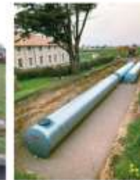
Travaux de mise en place de la réserve incendie enterrée
