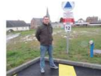
Reserve incendie enterrée laissant visible un espace herbeux
