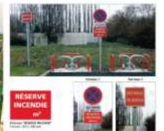
Signalisation de la présence d'une réserve incendie enterrée
