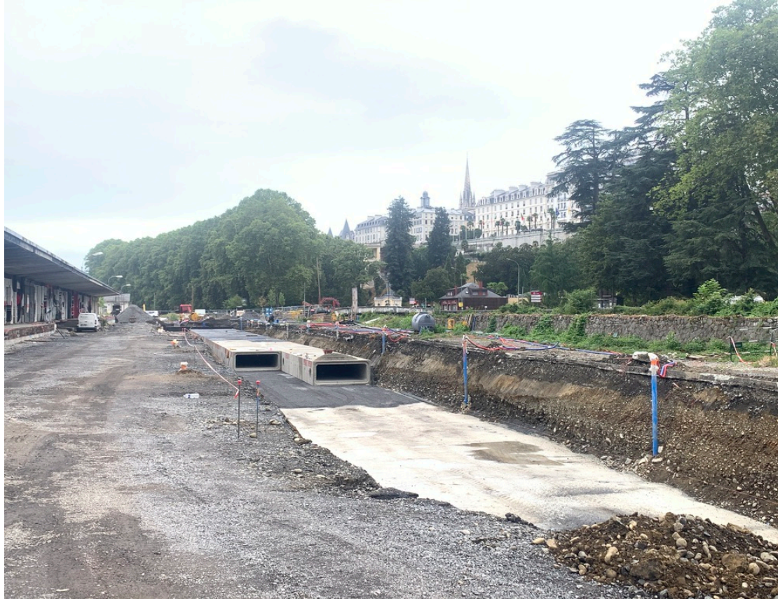
Rabattement Gare Multimodal de Pau, juin 2022.
