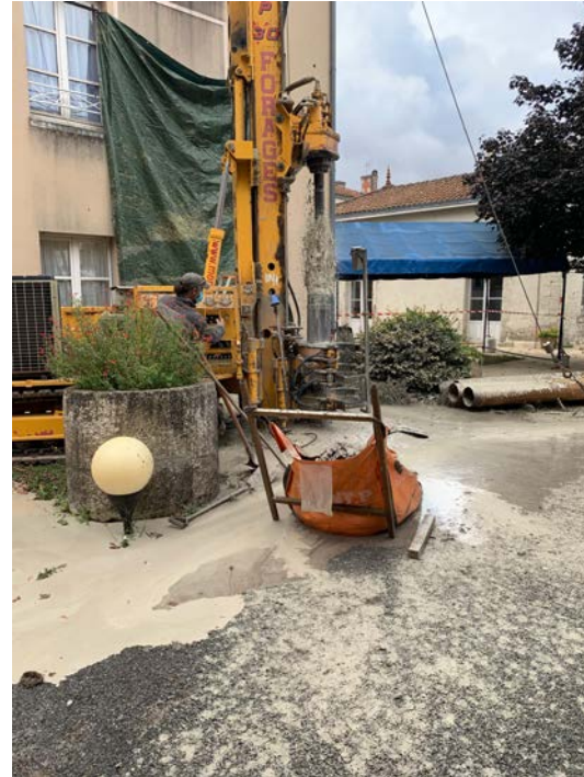
Chantier de forage
