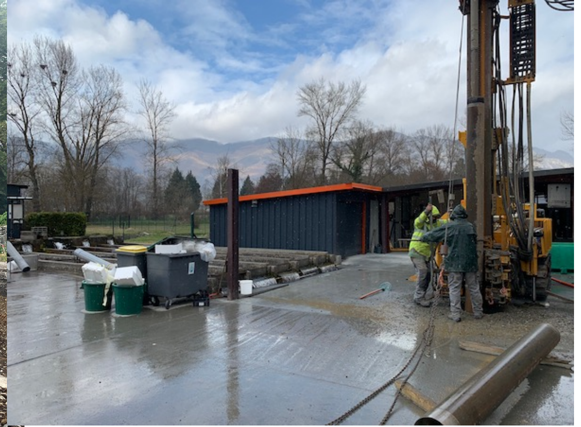
Forages Géothermiques Lau-Balagnas, mars 2020
