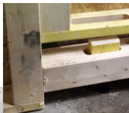
Fixation R+2 et R+3 : au dessus + insert bois en dessous
