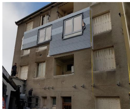
Levage et pose à l'aplomb
