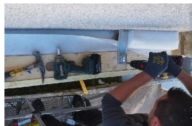
Fixation R+2 et R+3 : au dessus + insert bois en dessous
