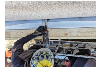
Fixation R+2 et R+3 : au dessus + insert bois en dessous
